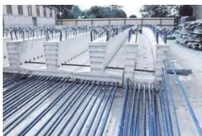
Fertigteile für eine Betonbrücke, die zwischen Tönning und Husum eingebaut werden soll.
